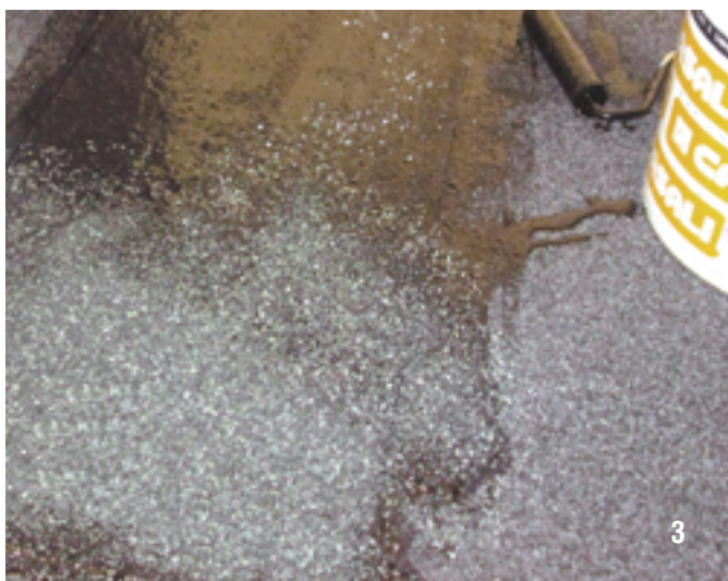
3. Semina a fresco di ardesia in scaglie su ultima mano abbondante di DERMARUBBER S/P, come protezione ai raggi UV
